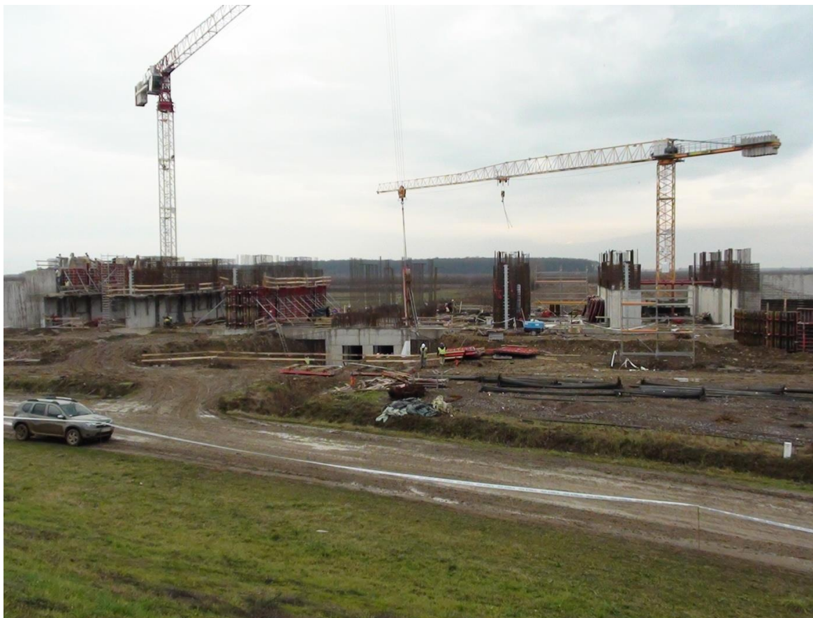
Az épülő beregi komplex árvízvédelmi tározó
