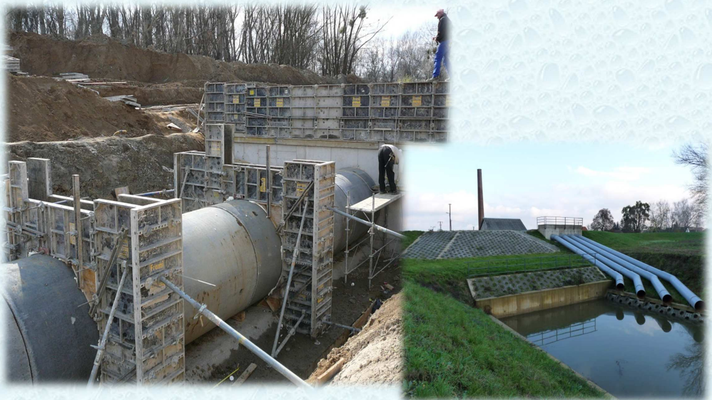
A Felsőbereckin épülő új gravitációs zsilip
