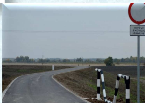
Aszfalt burkolattal ellátott korona
