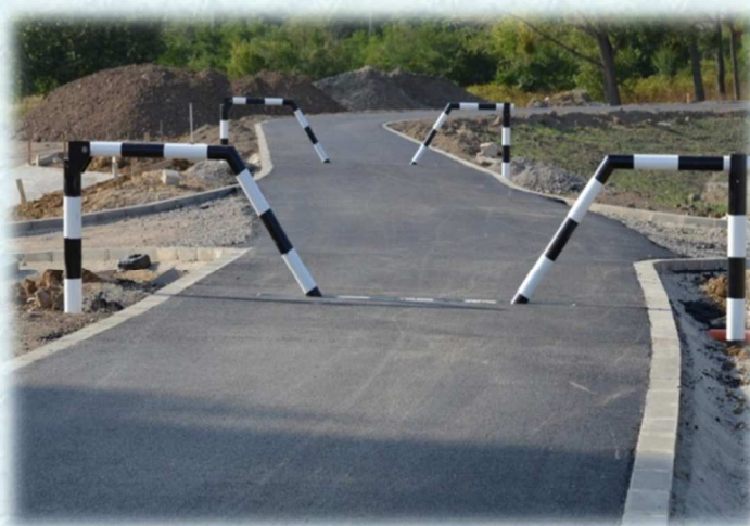
4,6 km új aszfaltburkolat
