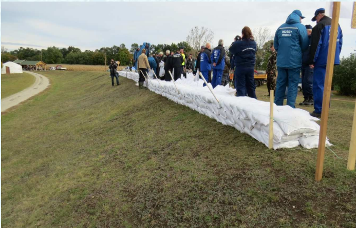
11. kép Töltésmagasítás homokzsákkal
