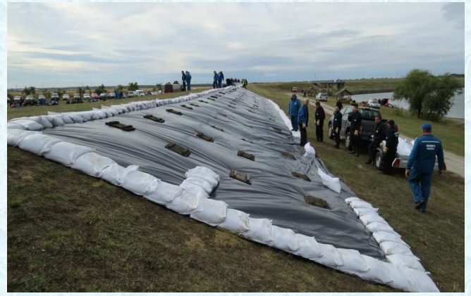
10. kép Hullámverés elleni fóliaterítés
