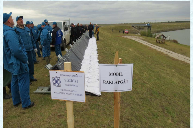
12. kép Töltésmagasítás mobilgáttal
