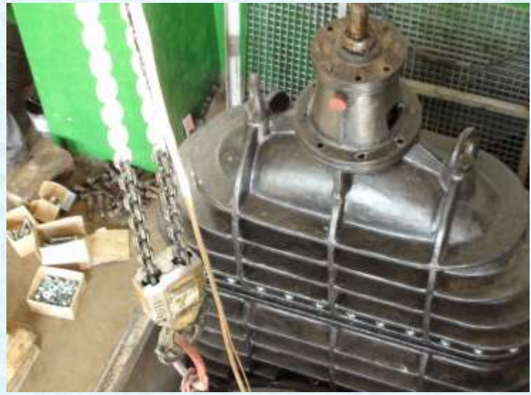
Ladislav-i (Markovce) belvízátemelő szivattyútelep gépészeti felújítási munkálatai (átemelő szivattyúk kiemelése)
