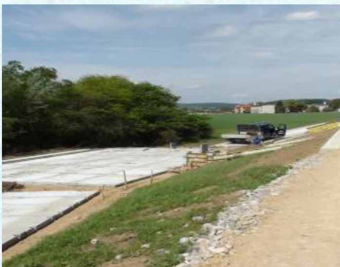
Mobil belvízátemelő szivattyúállomás építése Borsiban
