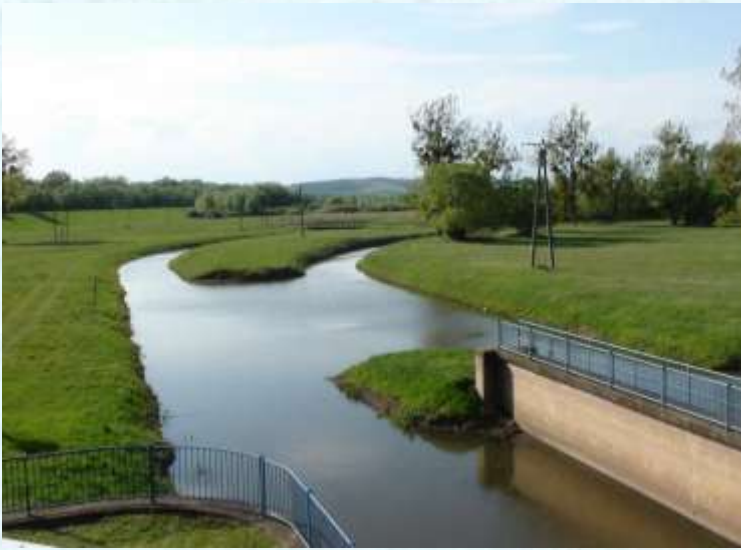
Kamenna Molva-i (Oborín – Kucany) belvízátemelő szivattyútelep (mentesített oldali belvízcsatornák)
