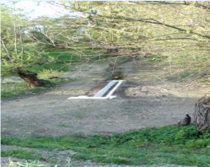
Hrani- belvízátemelő szivattyúállomás (a befogadóba történő vízbevezetés kialakítása)
