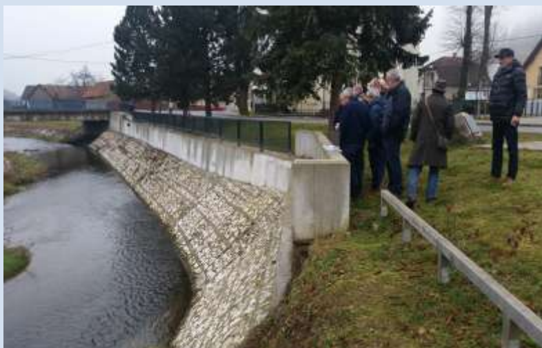
Kolcsó patak rendezett szakaszai
