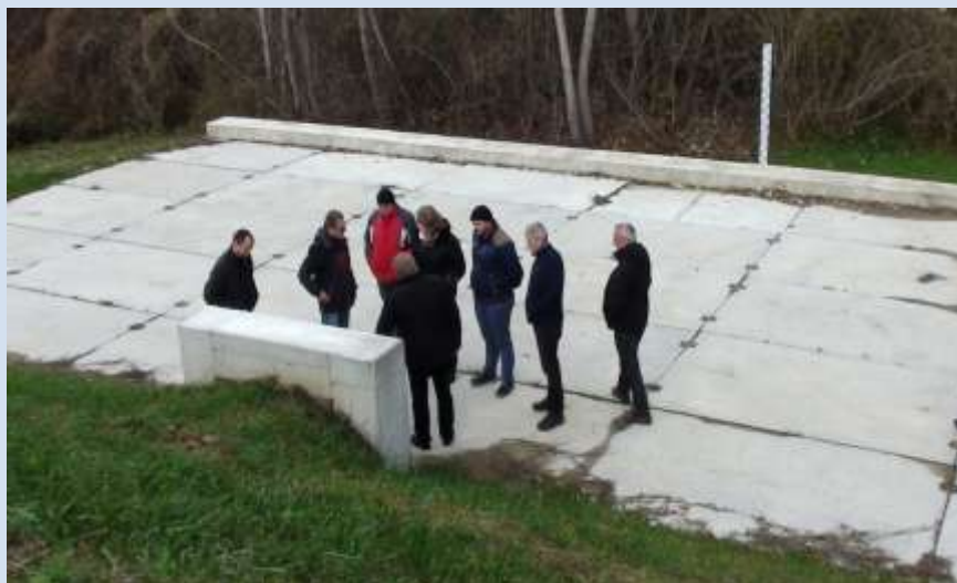
Mobil szivattyú állomás a Bodrog folyó jobb parti védőtöltése mellett, Szőlőske térségében
