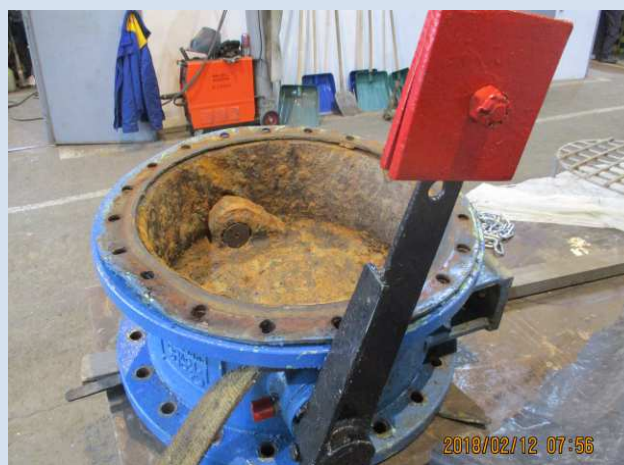
Tiszabábolnai-II. sztp. 2. sz. gép csappantyú javítása
