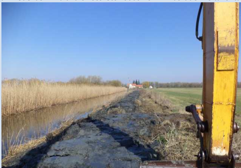
Taktaföldvári sztp. előtti mederszakaszon összetorlódott uszadék eltávolítása
