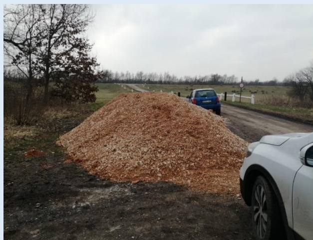
A 08.04. Inérhát-tokaji árvízvédelmi szakaszon nyomvályús töltéskorona
