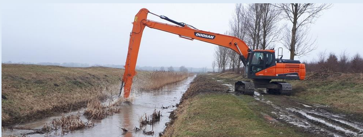
Tiszakarádi-összekötőcsatorna kotrása
