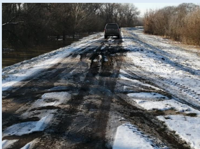
A 08.04. Inérhát-tokaji árvízvédelmi szakaszon nyomvályús töltéskorona
