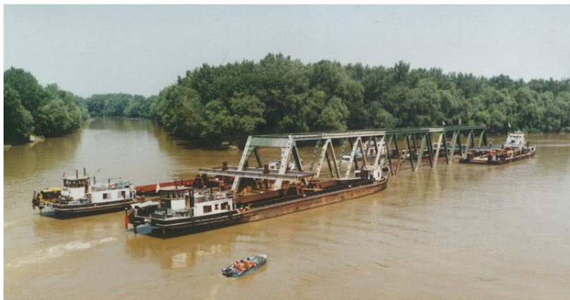
Úton a polgári híd acélszerkezete... A tokaji közúti hídról készített fotón éppen a Bodrog torkolata előtt látható, az alacsony hídnnyílás miatt vízbe süllyesztett szállítmány
